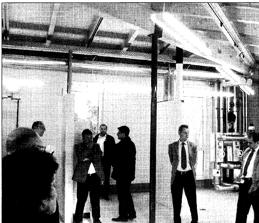
Beim ersten „Waiblinger Energieforum Wirtschaft“ haben die Teilnehmer aus Waiblinger Unternehmen auch die hochmoderne Heizzentrale der Stadtwerke besichtigt. Foto: Läßle
