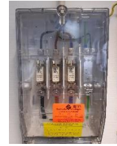
Beispiel Hausanschlusskasten
